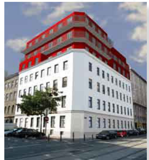
Das Gebäude Knöllgasse 23 nach der Sanierung.
