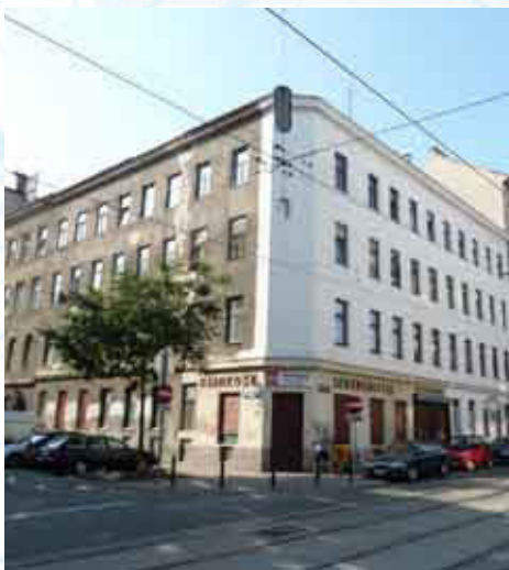
Das Gebäude Knöllgasse 23 vor der Sanierung.
